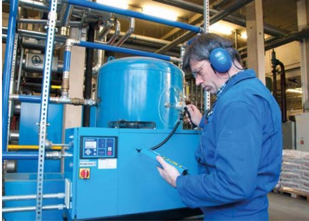
El monitor de fugas Boge es una solución sencilla y eficaz, capaz de medir automáticamente las pérdidas y mostrándolas en la pantalla del control del compresor. Durante las paradas de la empresa, el monitor de fugas Boge mide automáticamente los tiempos de funcionamiento en carga cuando el compresor solo trabaja para compensar fugas. Ese tiempo se muestra extrapolado al resto del año. Esta información permite valorar cuando
