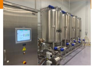
Consideraciones para diseñar el CIP. El propósito principal del CIP es eliminar la suciedad física y los residuos, así como las bacterias. Se utiliza comúnmente para equipos con tuberías, depósitos y llenadoras, donde el CIP emplea flujo turbulento (tuberías) o pulverización (tanques), pero también se puede hacer con inundación y agitación. Además de garantizar que los equipos estén en condiciones higiénicas aptas para la producción, el CIP también desempeña otras funciones importantes.
