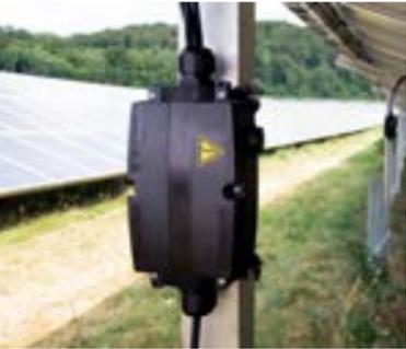
FieldPower PV de Weidmüller agrupa desde 2 hasta 4 strings fotovoltaicos individuales en 1 salida, aprovechando todas las ventajas de un sistema de cableado distribuido.
