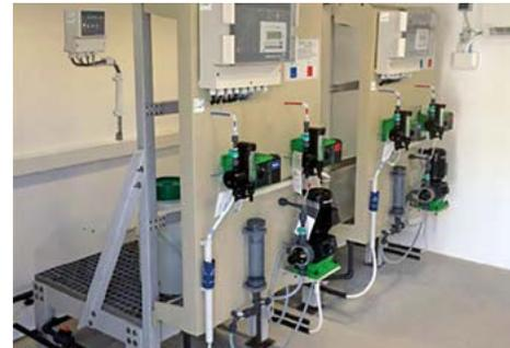
Desde clorEP diseñan y ejecutan proyectos de dosificación y desinfección de aguas potables. Llevan a cabo proyectos llave en mano de instalaciones con equipos de generación de dióxido de cloro "in situ" para garantizar la desinfección del agua potable de una forma eficaz con el fin de eliminar todo tipo de gérmenes patógenos con un efecto residual desinfectante prolongado en el sistema.
