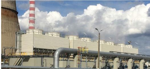
Las torres de refrigeración de la serie PU son refrigerantes atmosféricos de tiro inducido en contracorriente. Se caracterizan por contar con una estructura formada por perfiles de PRFV pultrusionado, minimizándose la presencia de elementos metálicos en la torre.
