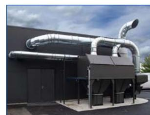
su modularidad además podemos adaptarle componentes de hasta 3mm para mejorar la resistencia al desgaste y a la abrasión. Todas las piezas se fabrican con un rango de diámetros entre 50mm a 1250mm. La calidad de la chapa y el acabado -sea galvanizado, inoxidable o pintado- está debidamente certificada y cada pieza lleva su código de trazabilidad.
