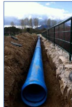
La tubería TOM® de PVC-O se muestra como una inmejorable solución para el transporte de agua a presión, debido a sus excepcionales propiedades físicas y mecánicas que garantizan una altísima vida útil, y también por su inalterabilidad química. Garantizan un consumo energético eficiente, ya que se reducen al mínimo las pérdidas de carga, y transportan mayor caudal de agua gracias a su mayor capacidad hidráulica.
