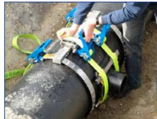
El nuevo desarrollo lleva implícito un sistema de fijación y de raspado de la tubería conjunto. Esta herramienta realiza las dos funciones, la de raspado de la tubería y la de fijación de la toma, durante el proceso de soldadura y enfriamiento. Se trata de una herramienta realizada por completo por Georg Fischer.
