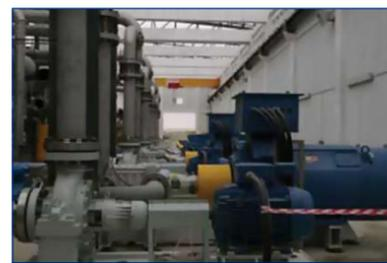
tipo en el África subsahariana, y es un activo vital para el suministro de agua en un país donde el 98% del territorio es árido o semiárido. Los motores WEG, de potencias entre 18,5 kW y 750 kW, accionan las bombas que se consideran cruciales para un funcionamiento fiable de la planta.
