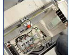
La solución de Schneider Electric se basa en el sistema de canalizaciones eléctricas prefabricadas Canalis KS e incorpora cajas de derivación de conexión sencilla. Su diseño "Plug & Play" garantiza una configuración rápida y segura, minimiza los tiempos de instalación y dota a la solución de gran flexibilidad ante nuevos entornos. iBusway incluye también un software que permite simplificar el diseño de la arquitectura y la supervisión la instalación.
