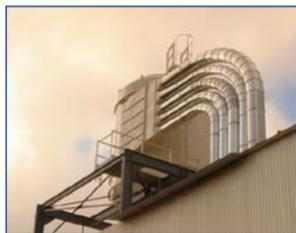
ROS® fabrica su tubería patentada (Sistema "MULTIFORM") en chapa galvanizada e inoxidable, en espesores de 0,6 a 1,0mm. y comercializa tubería KMH® en acero al carbono pintado, galvanizado en caliente y acero inoxidable, en espesores que oscilan entre 1,5 a 3,0mm. dependiendo del material.
