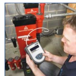
Los secadores de aire comprimido de dos etapas son los dispositivos más comunes de obtención de aire comprimido seco. Estos secadores disponen de dos columnas de secado; mientras una columna ejerce su función de secado la otra se encuentra en la etapa de regeneración. Dado que las condiciones de entrada al secador (caudal, temperatura y presión) varían, su eficiencia puede verse afectada.
