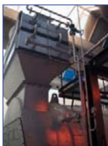
En calderas de aceite térmico la temperatura del fluido transmisor de calor puede ser bastante alta (hasta 400°C, dependiendo del tipo de aceite térmico) por tanto las temperaturas de humos a la salida de la caldera también acostumbran a ser altas y existe un gran potencial para ahorrar energía, recuperando calor.
