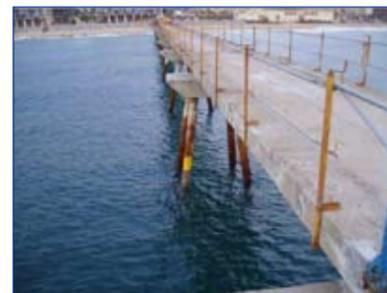
y aceites denominado PETROLATUM, que convierten el sistema en la solución ideal contra la corrosión. Este material mantiene la cinta permanentemente húmeda y flexible de tal forma que evita que el oxígeno (principal fuente de corrosión) entre en contacto permanente con el acero, no se agrieta, despegue o endurece con el paso del tiempo como puede suceder con cualquier pintura y se puede aplicar fácilmente bajo el agua.
