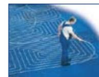
Uponor presenta su novedoso sistema de climatización invisible, integrado por un circuito de tuberías que cubre toda la superficie del suelo, a través de las cuales circula agua a la temperatura deseada, para proporcionar calefacción en invierno y refrigeración en verano. Sobre estas tuberías se extiende una fina capa de mortero de cemento que actúa de emisor uniforme en toda la superficie rematando la instalación con el pavimento.
