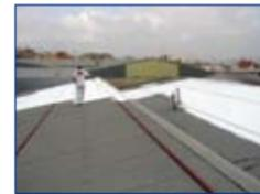
Esta pintura evita el recalentamiento de la superficie y sus efectos de dilatación-contracción, evitando las consecuencias de dichos efectos (resquebrajamiento, roturas, combamientos, etc.). De esta forma se incrementa la vida de las cubiertas y se reducen los gastos de mantenimiento, así como los gastos de refrigeración del interior. Esta pintura, de aplicación rápida y económica,
