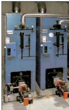
ro, con una cámara de reserva o acumulación que les da ventaja sobre otros generadores de producción rápida. La calidad del vapor producido, es del orden de un 15 a un 20% superior al de otros sistemas de obtención de vapor. Sus dimensiones son reducidas, con lo que se ahorra espacio. Las pérdidas por radiación son mínimas al verse favorecido por un doble aislamiento.
