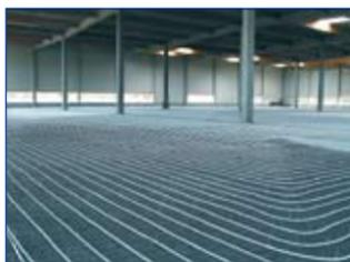
naves evitando que se impongan condiciones estéticas derivadas de los sistemas de climatización. Se trata de un sistema de fácil instalación y mantenimiento. Además, supone un importante ahorro de consumo energético. Con el sistema Uponor el factor clave es la temperatura radiante del suelo, por lo que si cambia la temperatura del aire dentro de la nave la sensación de confort
