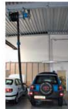
Instalación centralizada para humos de soldadura mediante brazos articulados
