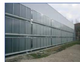
obstáculos, y permitir un mayor número de configuraciones posibles del campo solar. Con posibilidad de conectar en paralelo hasta 60m2 de superficie de captadores gracias a su hidráulica interna de funcionamiento "low flow". Su
