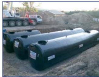
fecales como una necesidad para la industria. Con el lanzamiento de su sistema de plantas compactas prefabricadas en chapa de acero Oxycompact, Estaciones Depuradoras S.A. ha marcado un punto de inflexión en la industria del tratamiento de vertidos, simplificando al máximo el manejo y minimizando su mantenimiento.
