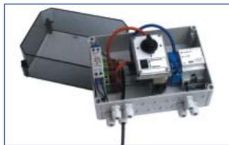
Según el Real decreto, RD 1663-2000 sobre la conexión de instalaciones fotovoltaicas a la red de baja tensión, se manifiesta que debe existir un interruptor con la finalidad de proteger a las personas en el caso de alguna derivación de algún elemento de la parte continua de la instalación.
